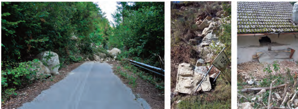
Figura 2: Sinistra: Crollo di blocchi che ha interrotto la strada tra la Salaria e il paese di Tufo (AP); Centro: Blocco crollato su un cartello stradale all'ingresso di Tufo; Destra: Muro di una abitazione di Capodacqua (AP) danneggiato da un blocco rotolato dal versante soprastante Fonte: ISPRA
